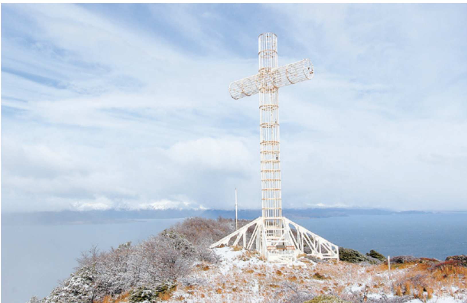
La actual Cruz de los Mares, instalada en el cabo Froward, tiene 24 metros de altura y está conformada por elementos tubulares metálicos y pernos de acero.
