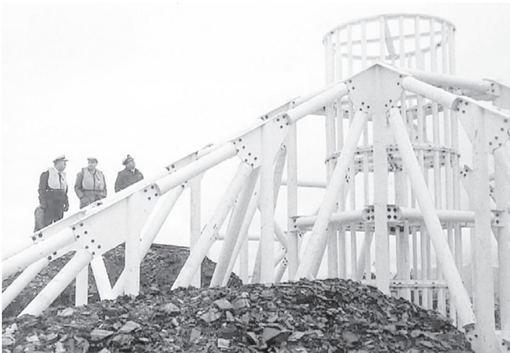
La fotografía tomada en enero de 1987 muestra el avance de la construcción de la pesada estructura.
